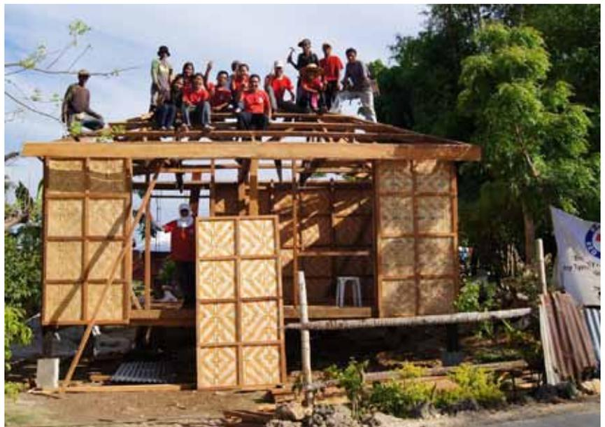
Abb. 14\_ Fertigstellung eines Dachstuhls
