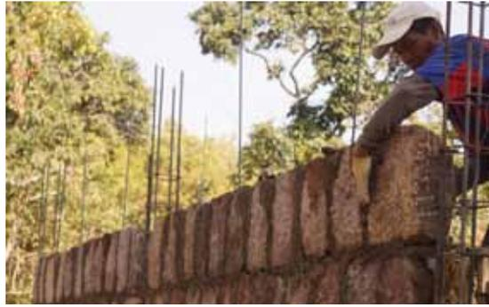
Abb. 59\_ Mauer aus Vulkangestein zwischen Stahlbetonstützen
