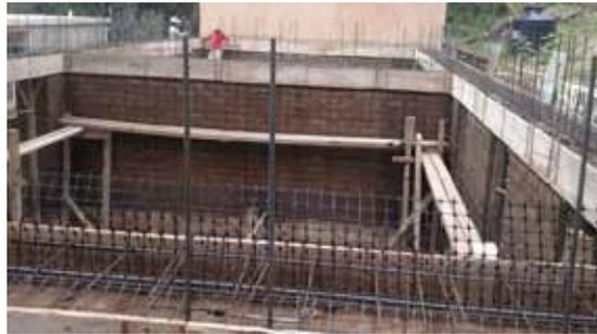
Abb. 60\_ Geogitter werden in die Bewehrung des Ringbalkens eingeflochten
