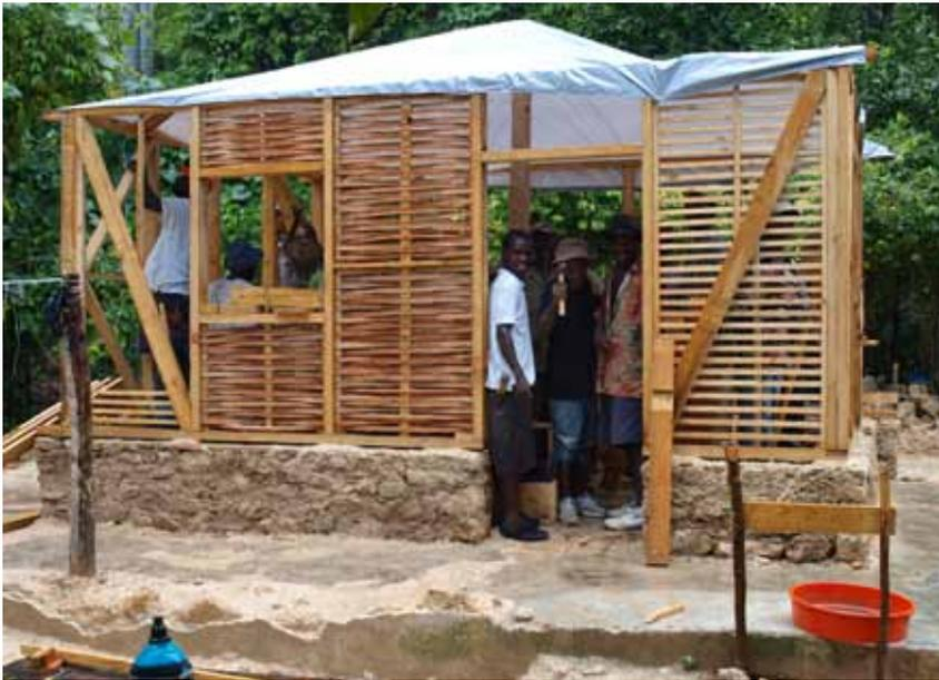
Abb. 26\_ Eines der ersten Häuser zu Ausbildungs- und Demonstrationszwecken (Clissage-Technik)
