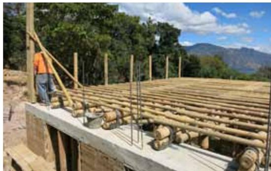
Abb. 61\_ Decke mit Fischbauchträger aus Bambus; aus dem Ringbalken ragen die Pins
