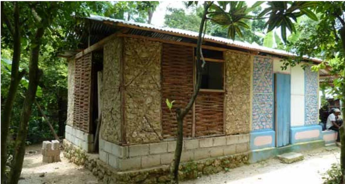
Abb. 28\_ Rivière Froide: Grundmodule mit eigenständiger Erweiterung, Clissage kombiniert mit Steinausfachung
