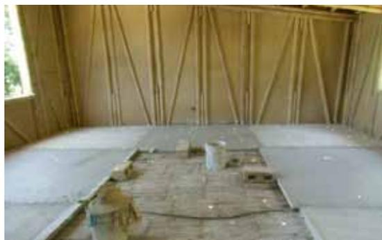
Abb. 62\_ Innerer Lehmewurf und Deckenaufbau im Obergeschoss
